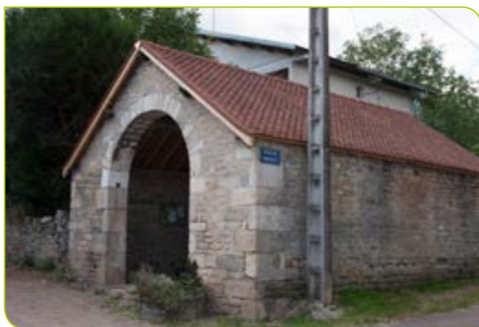
↑ La nouvelle toiture du lavoir rue du Pont
